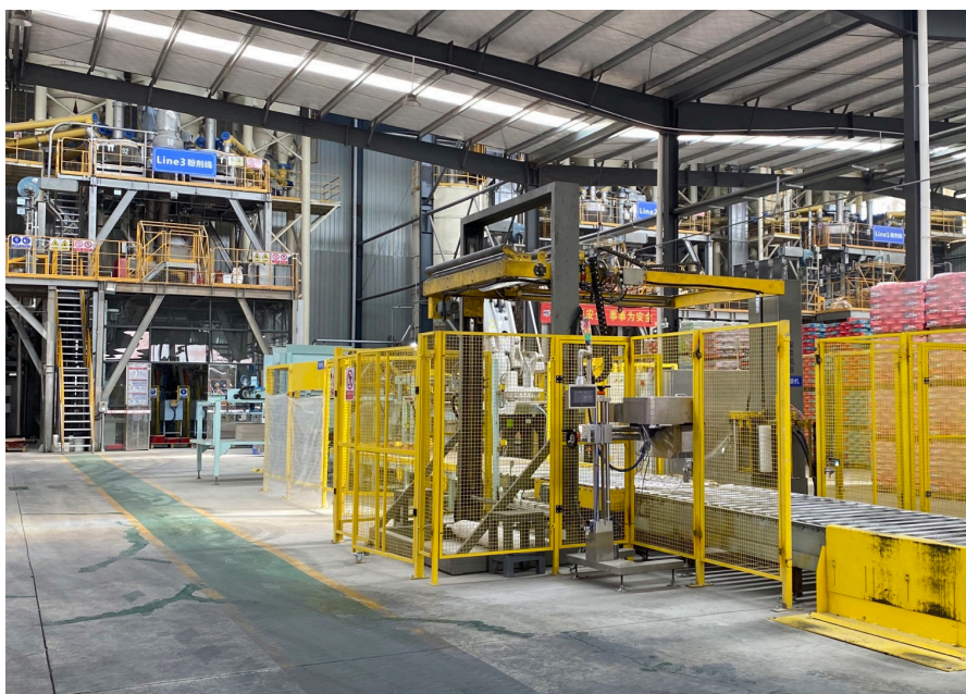
Nouvelle fabrique de mortier à Chengdu, en Chine.
