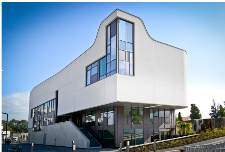
Les Studios de danse de Biarritz, ZAC Kleber (64), Biarritz - France. Photo : Samazuzu Architectes
